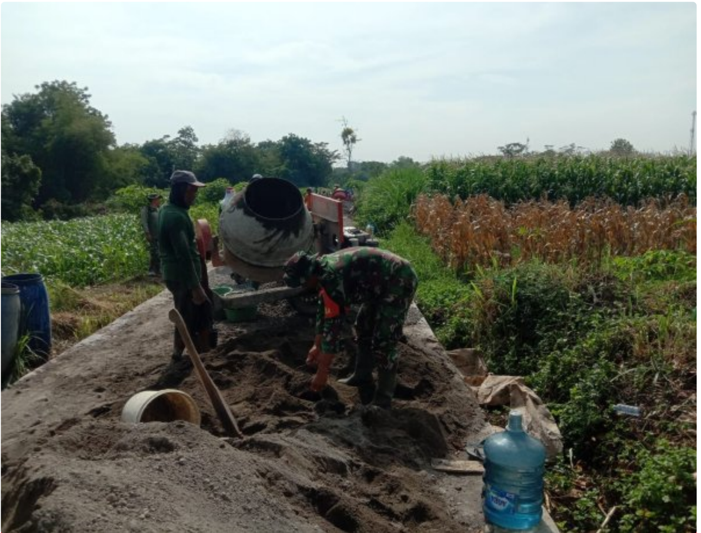
Betonisasi Pada Karya Bakti Klaten Bersinar (KBMKB) Desa Tulung Klaten
